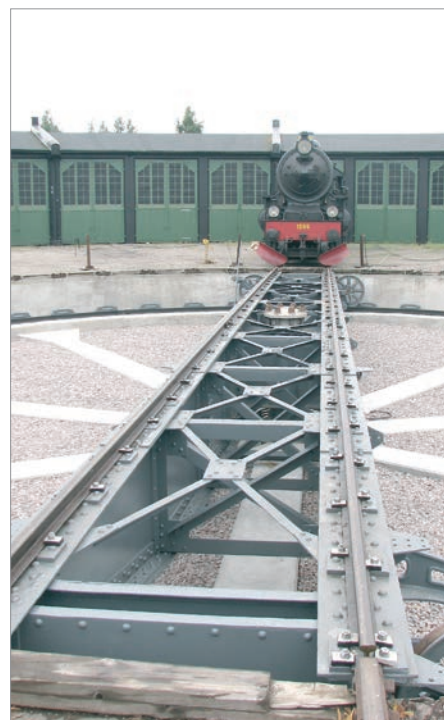
Den nyrenoverade vändskivan vid OKB-stallet. Den håller! Den har testats med F 1200. Tjänstevikt med fulla förråd 142,8 ton. Foto: Rolf Sten.
