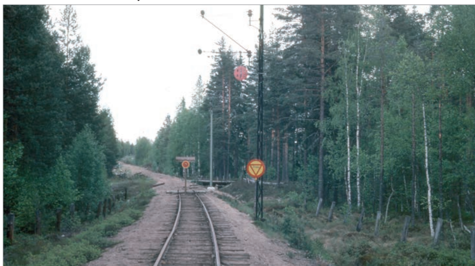
Hit men inte längre. Stoppmarkering gällande både järnvägstrafik och vägtrafik. NKIJ bana km 49+700 vid Musjöheden 1976-06-07 efter rivning av banan mot Finnshyttan. Foto: Hans Karlsson - Nyhlén.
