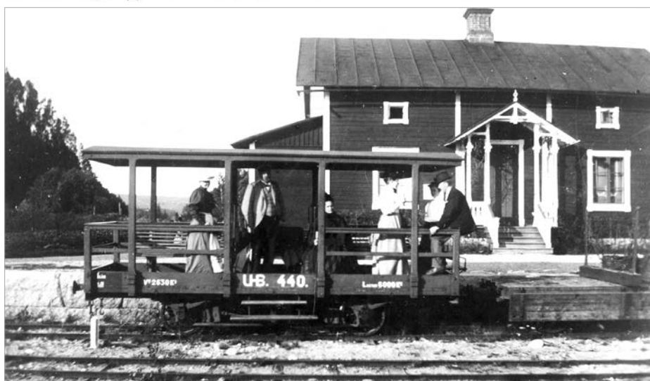
Skymnäs/Skymnäsboden 1890. UA/NKIJ västra slutpunkt. På bilden vagn UB440 apterad som så kallad sommarvagn. Foto: Nybergsska samlingen, Sveriges Järnvägmuseum.
