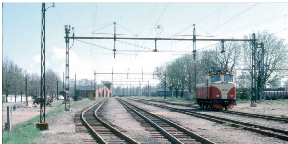
Bangårdsområdet, Karlstad Östra 1977-05-20. Detta var en av de få stationer som hade kontaktledningsbryggor. Lokstallet syns borta till vänster och på "nedre bangården" står några internvagnar, använda av banavdelningen. Foto: Hans Karlsson-Nyhlén.
