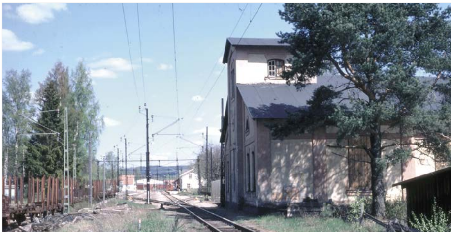
Infarten till Munkfors från söder, 1977-05-20. Lokstallet med inbyggt vattentorn precis vid spåret, vattenkastaren är dock borttagen sedan länge. Foto: Hans Karlsson-Nyhlén.
