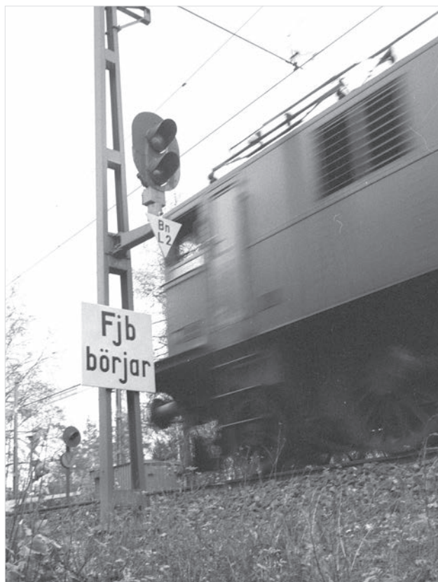
Utfart från Bollnäs, som var lokalbevakad fram till 1981. Den trekantiga tavlan under blocksignalen talade om att signalen skyddade en lastplats (Röste) på linjen. Bilden togs den 15 oktober 1970, samma dag som fjb driftsattes på sträckan Bollnäs – Järvsö. Foto: REKA, Sveriges Järnvägsmuseum.
