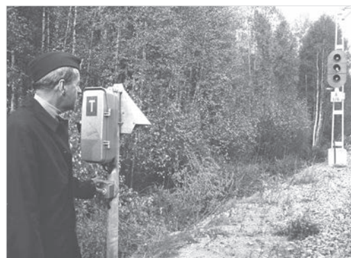
De fjärrstyrbara ställverken installeras i god tid innan fjb tas i bruk på banan. Här arbetar tågklararen i Vallsta norr om Bollnäs vid ett sådant ställverk den 15 oktober 1970. Antagligen var det sista arbetspasset; fjärrblockering Bollnäs – Järvsö togs i bruk samma dag. Foto: REKA, Sveriges Järnvägmuseum.
