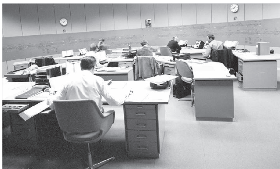
Stockholm C 1974. Elektronisk datorstödd CTC. Fortfarande används dock stora spårplanstavlor med kontrollampor. Foto: REKA, Sveriges Järnvägmuseum.
