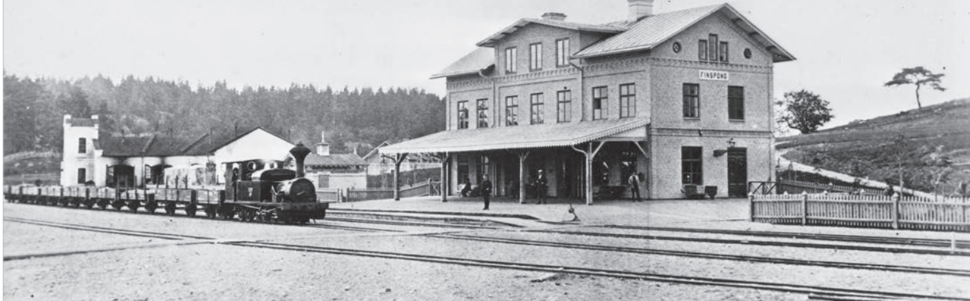
Finspång 1880. Mellan bruket i Finspång och Lotorp byggdes 1854 en 7,5 kilometer lång bana med spårvidd 891 mm. Hästar var dragkraft från början. Efter ombyggnad av banan ersattes hästarna 1876 av ångloket "Lotorp". På bilden syns loket klart för att dra iväg med tåget mot Lotorp. Bangård och byggnader tillhör Pålseboda - Finspångs Järnväg, 891 mm, vilken i sin helhet öppnades för trafik 19 september 1874. Denna bana var då den tredje trefotabanan som i sin helhet öppnades för allmän trafik. Foto: Sveriges Järnvägsmuseum.
