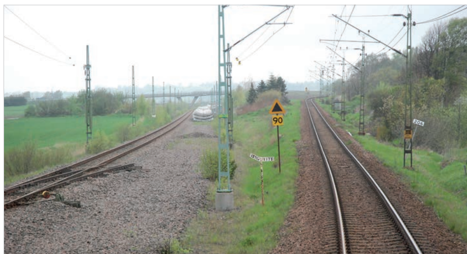
Upp över Hallandsåsen, stigningen börjar med 13 promilles lutning. Till vänster syns banvallen för det dubbelspår som leder till den blivande tunneln genom åsen. Än så länge bara belagt med ett spår. I skrivande stund, 30 maj, rapporterar Sveriges Radio att man nu har fått "hål" genom hela åsen. Foto: Gunnar Jonsson.
