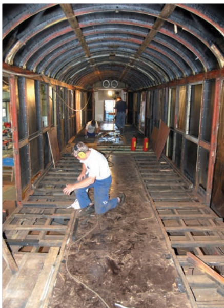
Förberedande arbeten inför inläggning av nytt golv i vagnen. Foto: Lennart Lundgren.
