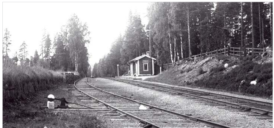
Born station på Gävle - Dala Järnväg 1907. Bortåt i bild är i riktning mot Falun. Foto: Sveriges Järnvägsmuseum.
