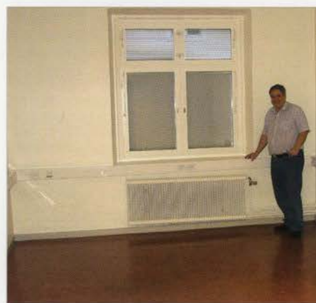
En nöjd projektledare i ett av de nyrenoverade kontorsrummen på Karlsborgsgatan 1. Foto: Rolf Sten.
