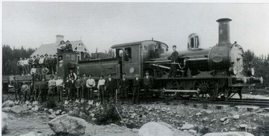
År 1902. Borås - Alvesta Järnvägs lok nummer 5 med byggnadståg. Grusning av den nyutlagda överbyggnaden (slipers och räls). Foto: Nybergiska samlingen, Sveriges Järnvägsmuseum.
