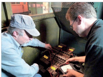
Mätning och kontroll av alla elkablars isolation. Foto: Lennart Lundgren. Bilden till vänster, foto: Gunnar Jonsson.
