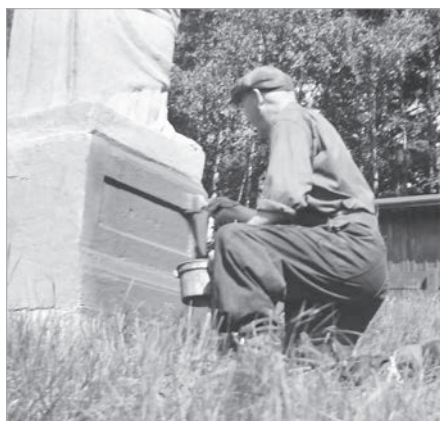
Den pensionerade lokföraren Oscar Andersson slammar en statysockel. Foto: Jan I Arvhult.
