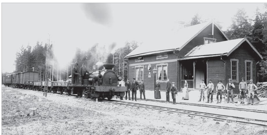
Marks station 1901 med lok Nr1 eller 2. Banan öppnades 1901-05-01 och arbetena kring stationen är ännu inte riktigt färdigt. Bild ur min fotosamling.
