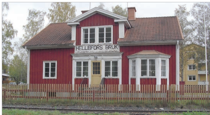
Före detta stationshuset, Hällefors Bruk. Foto 2010-10-05 Hans Rydebert.
