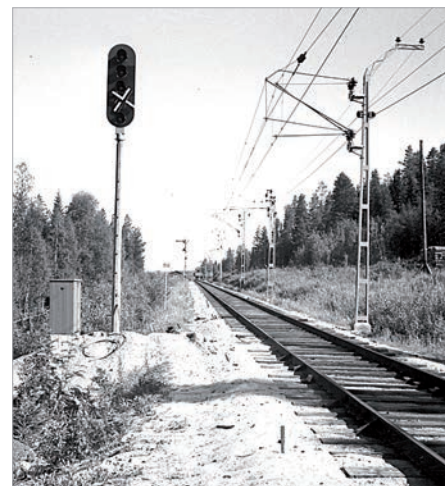
I samband med elektrifieringen, semaforerna byts ut och ersätts av ljussignaler. Här vid infarten till Hällnäs 1942. Foto: Sveriges Järnvägmuseum.
