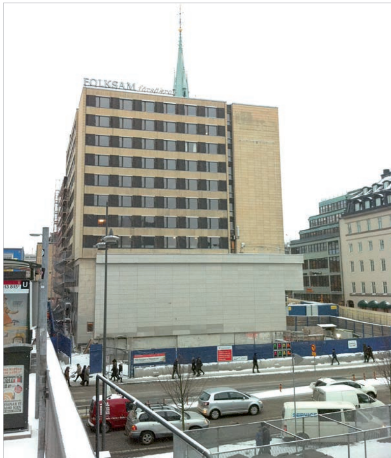
Hôtel Continental i Stockholm 2013 på väg att rivas. Byggställningar till vänster, det gamla annexet, nuvarande Hotel Terminus till höger. Den främre delen av hotellet revs redan 2010. foto: Mårten Dunér
