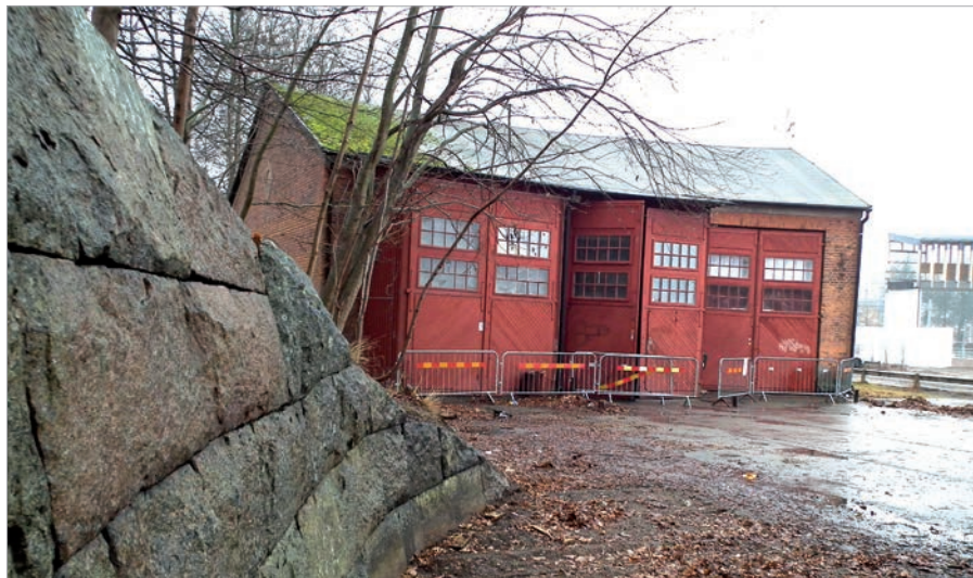
VTJ-stallet några dagar innan rivningen. Foto: 2014-02-18 Krister Persson.
