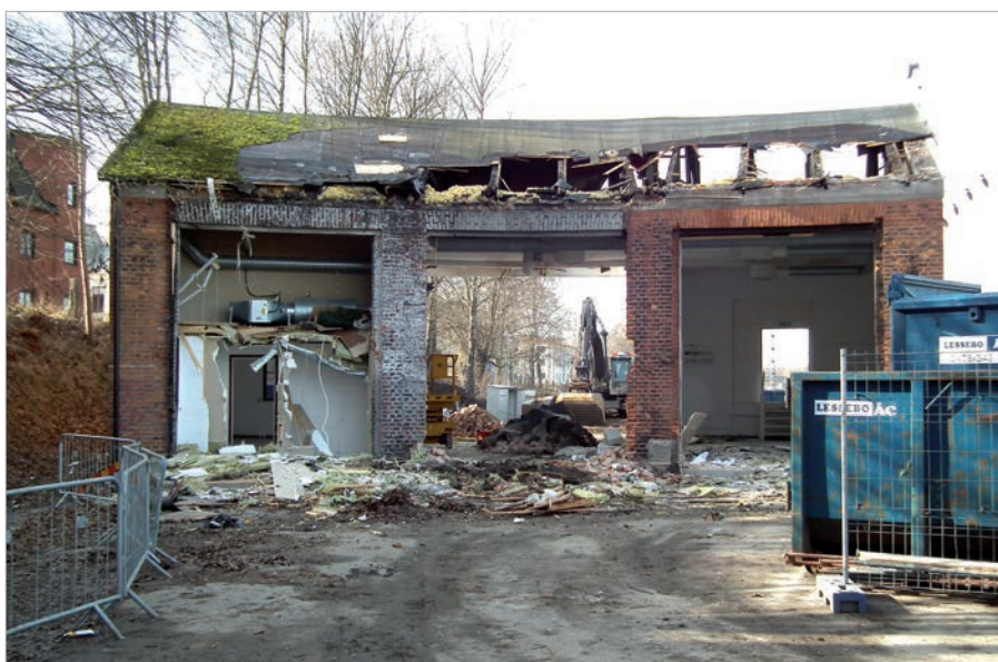
VTJ-stallet under rivning. Foto: 2014-02-24 Krister Persson.
