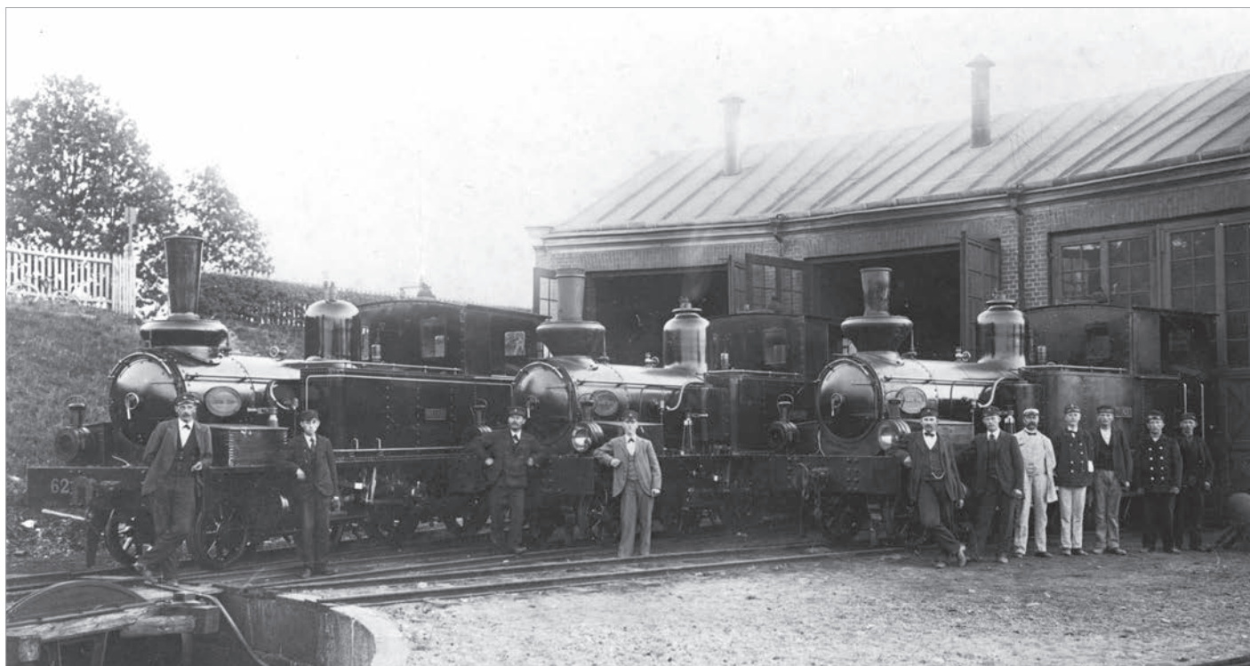
Då det begav sig. Växjö - Tingsryds Järnväg, VTJ, lokstall i Växjö, början av 1900-talet. Från vänster VTJ 62 "Helge", VTJ 60 "Wexiö" och VTJ 61 "Inge". Foto: Sveriges Järnvägsmuseum samlingsportalen.se KDAA09102.
