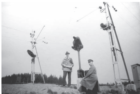
Signaler kopplas in vid en automatisk blockpost, troligen Bränninge mellan Södertälje och Järna.
