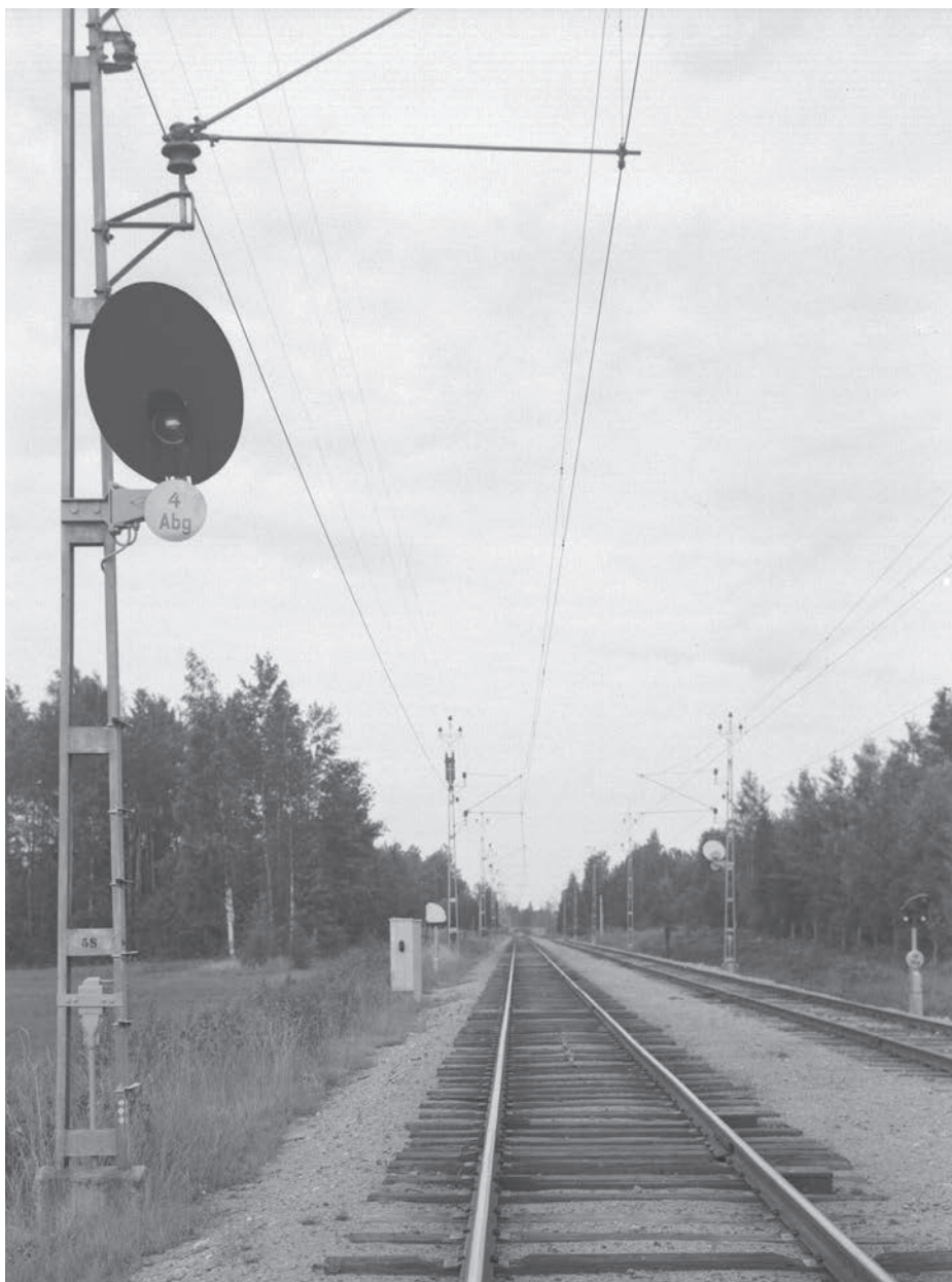
Strålkastaroch linjedvärgsignaler vid blockposten Adolfsberg, strax söder om Örebro
