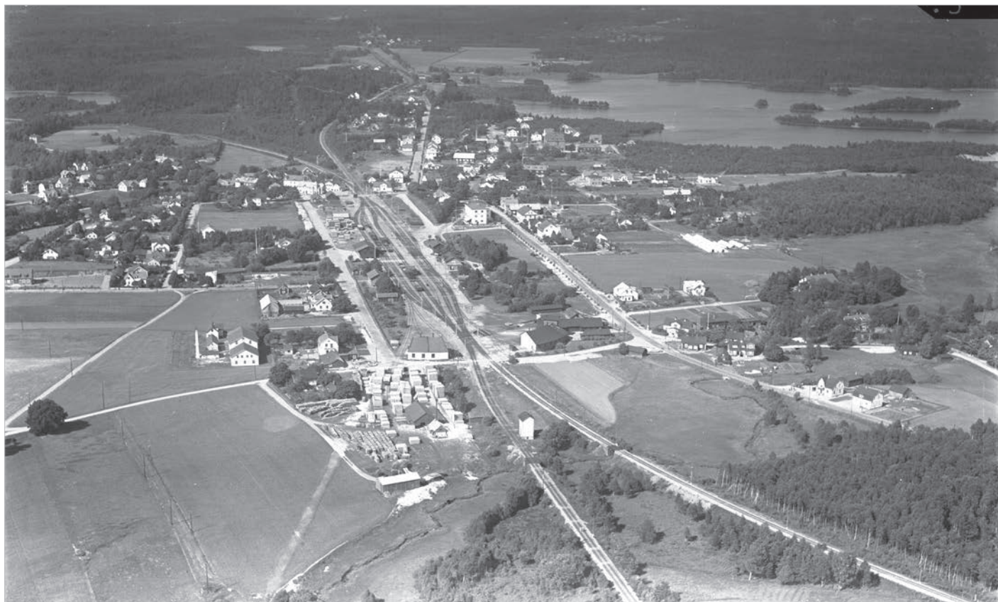
Denna bild från 1936 visar tydligt järnvägarnas sträckning. Carl Hising kom 1892 nedifrån till höger i bild från Hässleholm. Han fortsätter tämligen omgående med en kort järnvägsstump till en punkt strax utanför till vänster uppe i bild mot kyrkan. 1894 kommer Carls förra chef Petter Olsson nerifrån Helsingborg och anlöper stationen strax till vänster om Hising's järnväg. Petter och hans kompanjoner tänkte sig ett tag gå över Hising's järnväg i en viadukt i bildens nedre del, där Volvo idag ligger. För att sedan gå över Markaryd Södergård och vidare ut till höger i bild och öster om Getesjön. Men när Timsfors bruk kom in i beräkningarna ändrade man sig och drog sin järnväg norrut, upp i bildens mitt. Sin järnvägsstation, Markaryd västra, lade man mittemot Markaryds östra. Foto: Samlingsportalen.se KAFR00220 Sveriges Järnvägmuseum.
