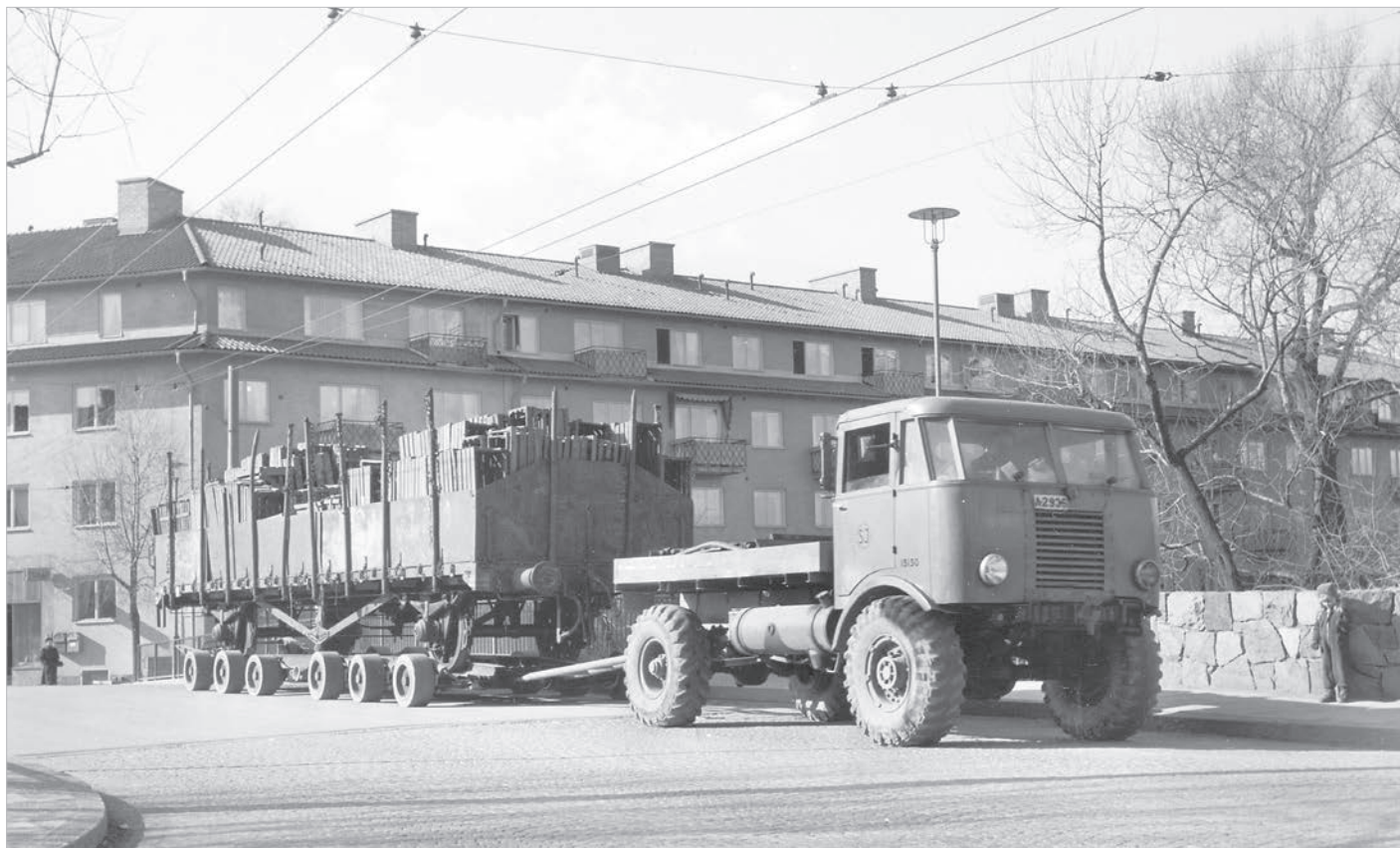
Stockholm - Reimersholme 1954. Transport av godsvagn upplastad på vagnbjörn Foto: jvm,KDAF07122 Samlingsportalen.se Sveriges Järnvägmuseum.
