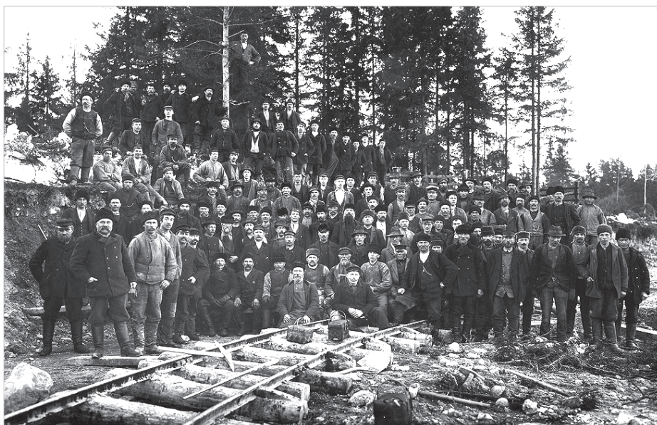
Arbetslag vid hamnbygget i Fredriksskans, Gävle. Fotot taget runt 1905. Foto: Sveriges Järnvägsmuseum, Samlingsportalen.se
