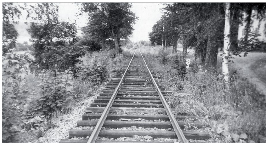
Spårläget vid Sund 1959. Spårvägens räls tillverkad av Workington Iron and Steel Company 1923. Ordentlig upprustning med rälsbyte och ny makadam företogs först vid förlängningen till Tunadal. Foto: Marc Donda.
