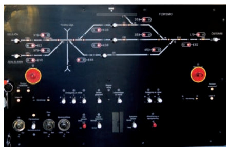
Vänstra bilden: Nuvarande ställverksplan i Forsmo teknikhus 2018. Till höger: Den gamla ställverksplanen visar hur bangården såg ut fram till 1980-talets slut. I dag finns ställverket på Sollefteå MJ-klubbs anläggning, där det fungerar utmärkt. Foton: Kenneth Landgren.
