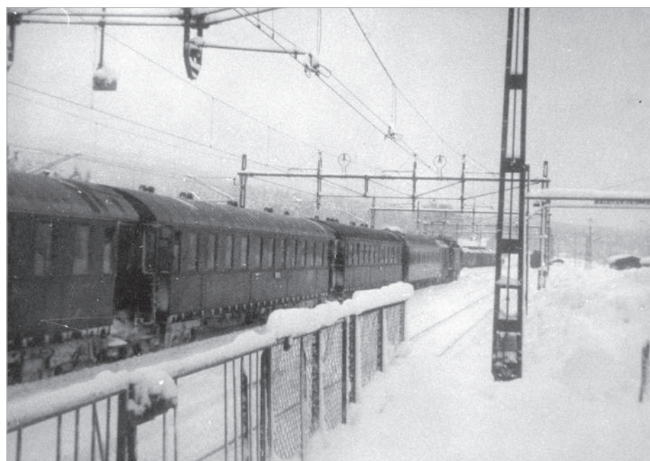
Lastkajen i Forsmo med det beryktade staketet med grindarna som först kunde öppnas när spänningen i kontaktledningen var bruten. Tåg 5352 gör uppehåll innan det fortsätter norrut. Foto: Kenneth Landgren.
