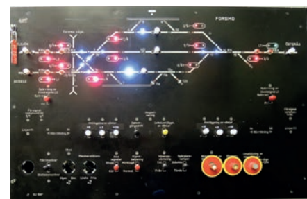
Vänstra bilden: Nuvarande ställverksplan i Forsmo teknikhus 2018. Till höger: Den gamla ställverksplanen visar hur bangården såg ut fram till 1980-talets slut. I dag finns ställverket på Sollefteå MJ-klubbs anläggning, där det fungerar utmärkt. Foton: Kenneth Landgren.
