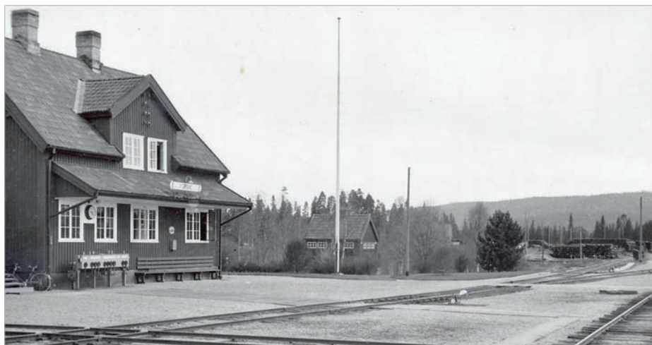
Forsmo station 1937, Telegrafverket har byggt sin impregneringsanläggning i södra änden av bangården med ett eget spår. Lastkajsspåret har lagts från magasinet fram till där kajen skulle byggas. På väggen syns postens skylt och brevlåda. Det stora vevställverket är placerat framför stationsbyggnaden. Bänken stod kvar till det "bistra" slutet då den sågades upp. Bakom flaggstången syns utedassen och förråd. Foto: Järnvägmuseum KDAE02425.
