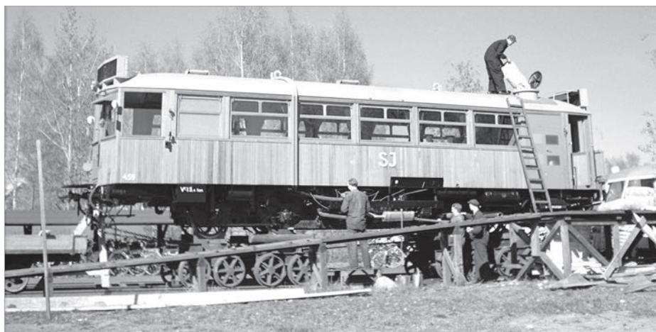
April 1942. Revision på Örebro huvudverkstad, installation av utrustning för gengasdrift. Statens Järnvägar, SJ X2p 459, ursprungligen Kalmar - Torsås Järnväg, KTsJ motorvagn 60. KBDN00656. Foto: Eric Lundquist, Järnvägmuseet KBDN00656.
