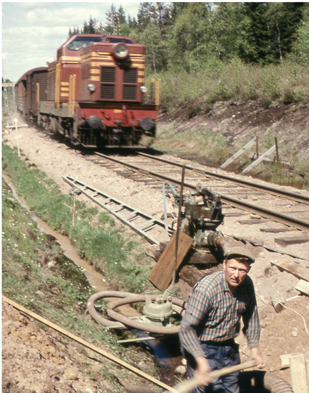
Bilden visar stolpsättning inför elektrifieringen av järnvägssträckan Borås - Alvesta. Den är tagen mellan Värnamo och Limmared i juni 1960. T 41 204 med persontåg passerar arbetsplatsen. Foto: Erik Sjöholm.
